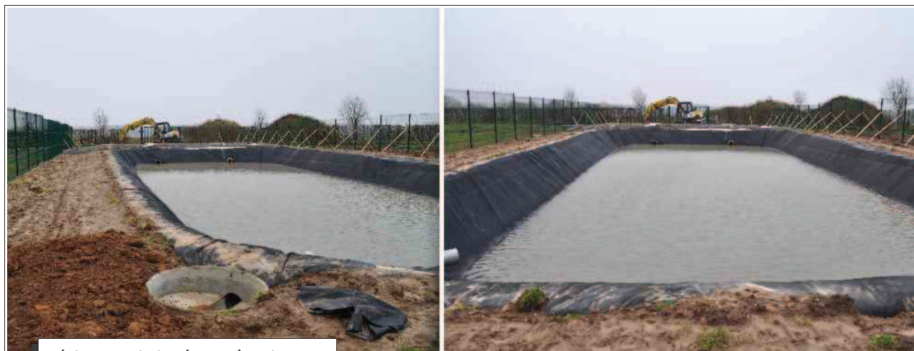
Réalisation de la réserve à ciel ouvert
